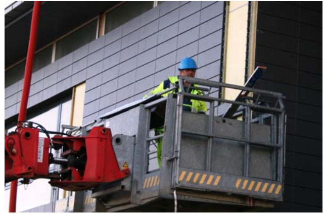
Travlhed med at få facaden færdig
